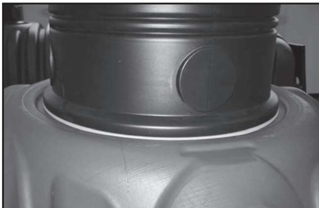
FIG.4 Install Riser
